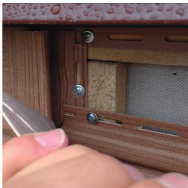
Саморезы вкручены в тело доборного элемента и края перфорации. Отсутствует зазор между шляпкой самореза и доборным элементом. Перекрыт вентканал.
