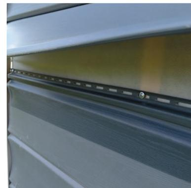
Неправильно смонтирована мембрана. Должна быть установлена до обрешетки. Нет зазора между мембраной и фасадным материалом.
